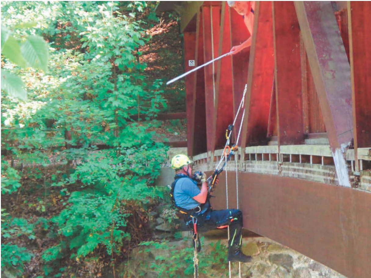
Prüfung Pfostenfuß durch Industriekletterer
